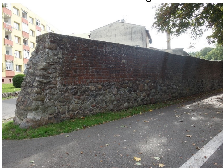
Odcinek muru nr.1 narożnik ceglano kamienny wraz z murem porośnięty glonami i chwastami. Spoiny zabrudzone miejscami spękańe
