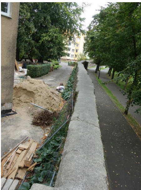
Korona murów. Pęknięcie i wybrzuszenie warstwy cementowej pokrywającej mur drobne ubytki zaprawy- korona porośnięta glonami
