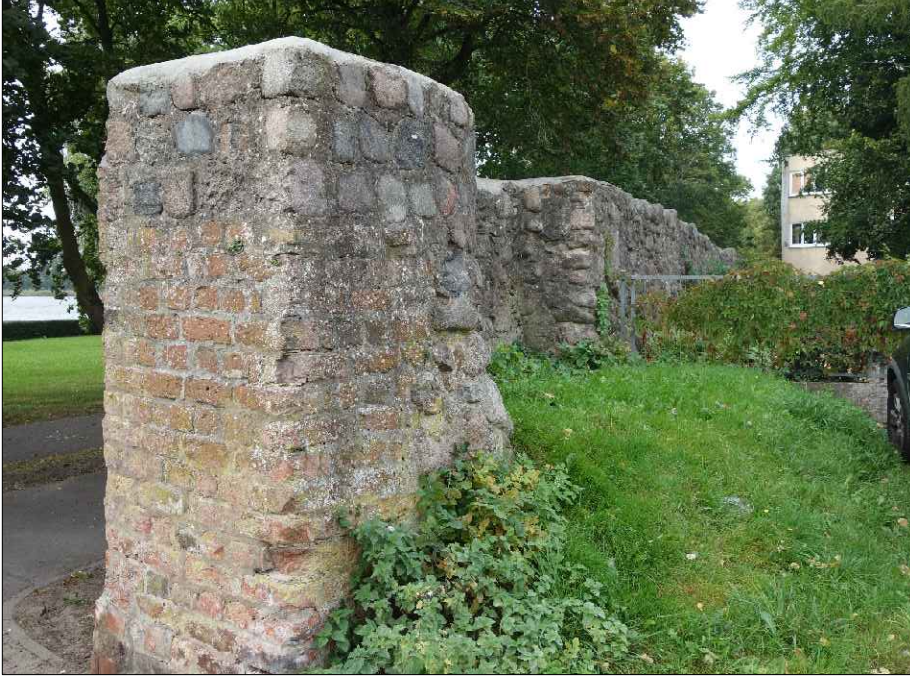
Wyszczerbione cegły, splekane i luzne spoiny cegiel z kamieniem - narożnik muru porośnięty gionami. Narożnik do odnowienia i hydrofobizacji
