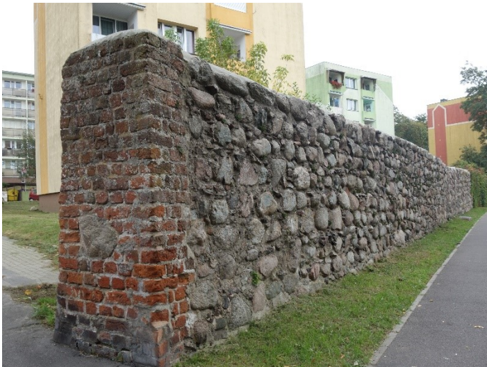
Odcinek nr.4 Narożnik, cegła wyszczerbiona, kamień porośnięty glonami .Odcinek muru porośnięty bluszczem ubytki zaprawy w spoinach .
