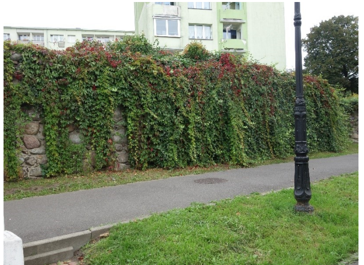
Odcinek nr.4 Narożnik, cegła wyszczerbiona, kamień porośnięty glonami .Odcinek muru porośnięty bluszczem ubytki zaprawy w spoinach .
