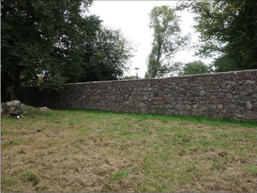
Mur kamienny i korona porośnięta gionami. Spoiny kamienne luzne wypuklane do uzupełnienia.Odcinek muru ceglanego porośnięty gionami i ubytki zaprawy w spoinach -cegły wyszczerbione
