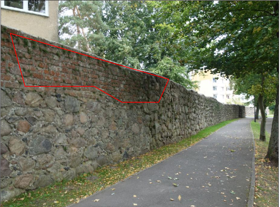
Mur kamienny i korona porośnięta gionami. Spoiny kamienne luzne wypuklane do uzupełnienia.Odcinek muru ceglanego porośnięty gionami i ubytki zaprawy w spoinach -cegły wyszczerbione
