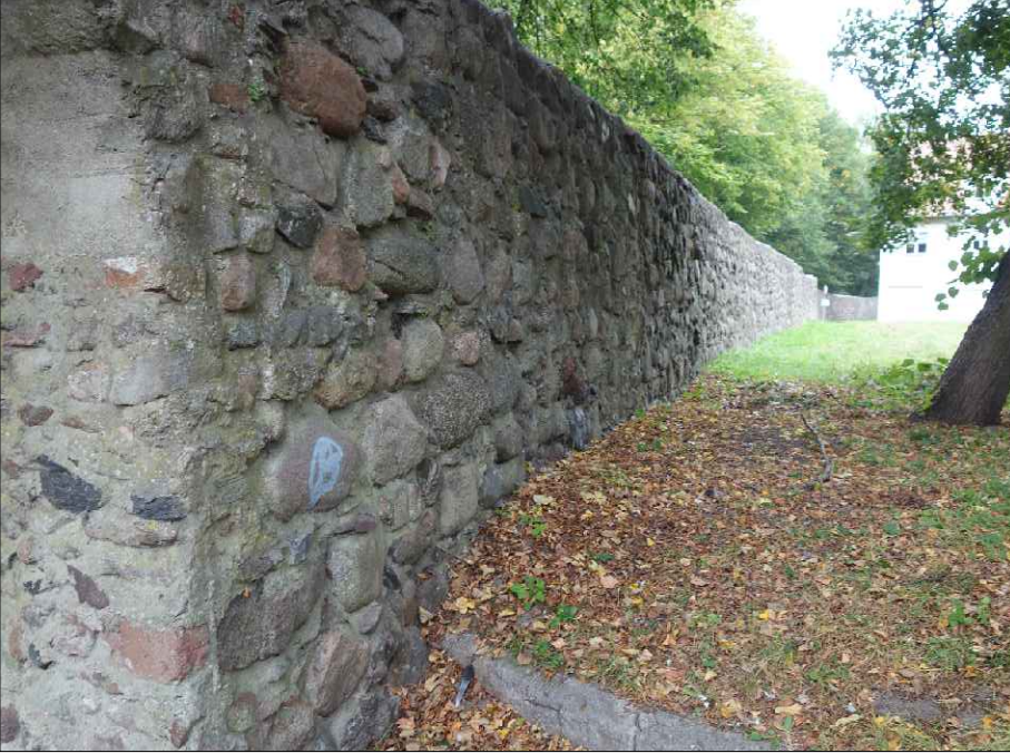
Sklepienia łukowe ( łęki) i korona porośnięta gionami. Spoiny luzne wypuklane do uzupełnienia Mur na odcinku występowania furt z kamienia porośnięty gionami.
