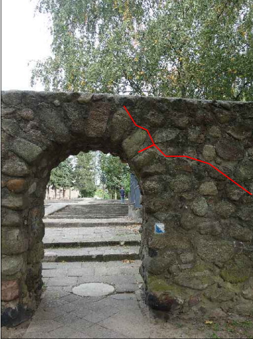
Sklepienia łukowe ( łęki) i korona porośnięta gionami. Spoiny luzne wypuklane do uzupełnienia Mur na odcinku występowania furt z kamienia porośnięty gionami.
