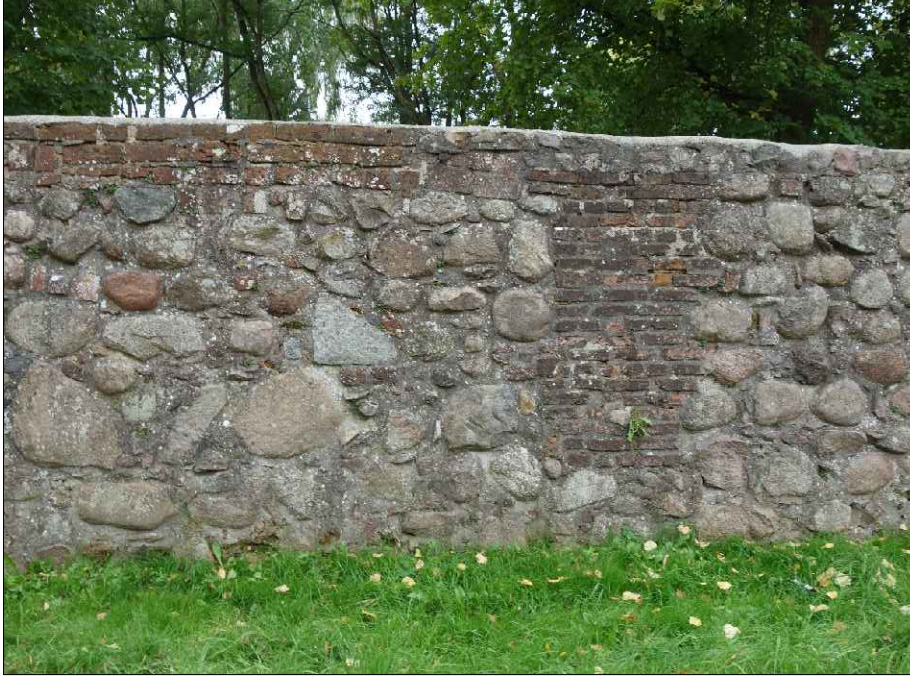
Mur kamienny i korona porośnięta gionami. Spoiny kamienne luzne wypuklane do uzupełnienia
