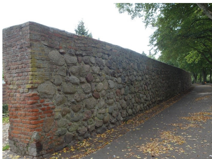
Odcinek nr.2 Pęknięty narożnik cegła i kamień porośnięte glonami .Mur z kamienia porośnięty glonami.
