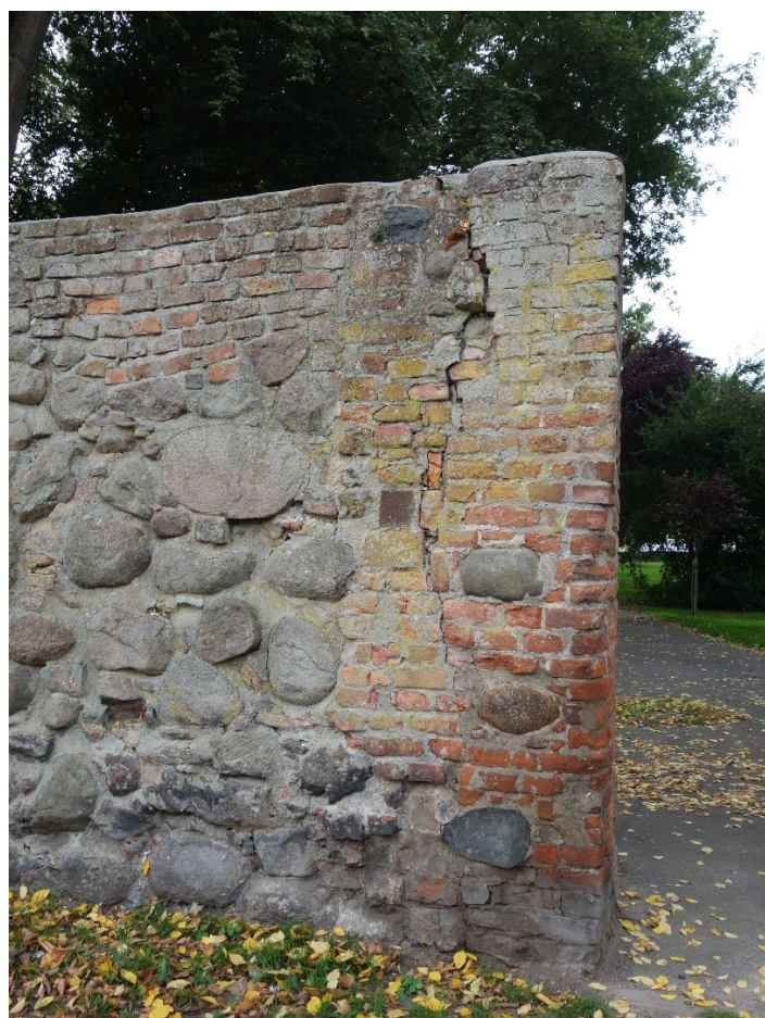
Odcinek nr.2 Pęknięty narożnik cegła i kamień porośnięte glonami .Mur z kamienia porośnięty glonami.
