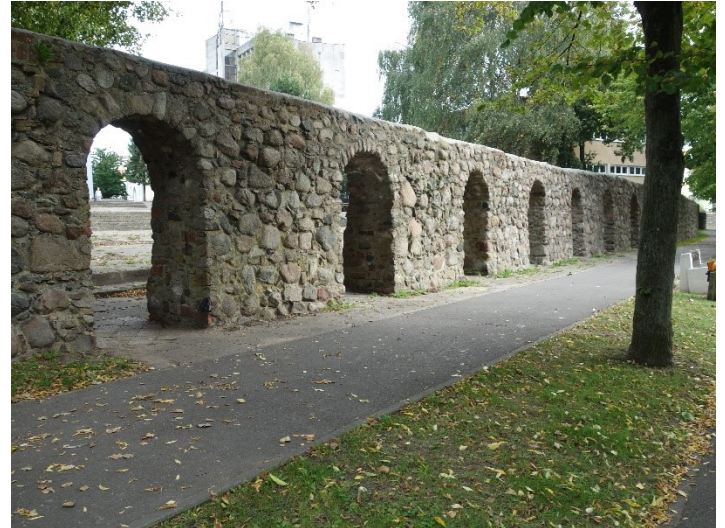
Odcinek nr.3 Narożnik, cegła wyszczerbiona, kamień porośnięty glonami .Odcinek muru z łękami porośnięty glonami ubytki zaprawy w spoinach .
