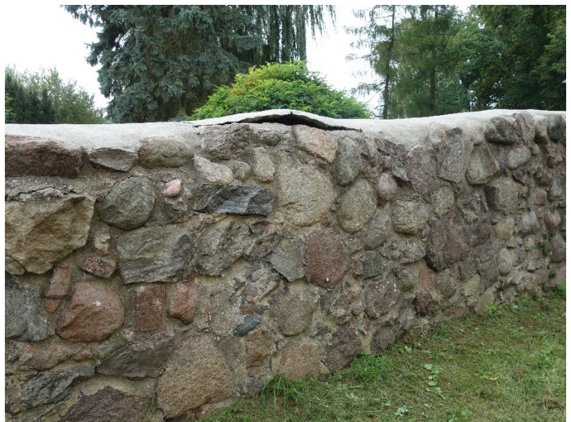
Korona murów. Pęknięcie i wybrzuszenie warstwy cementowej pokrywającej mur drobne ubytki zaprawy- korona porośnięta glonami
