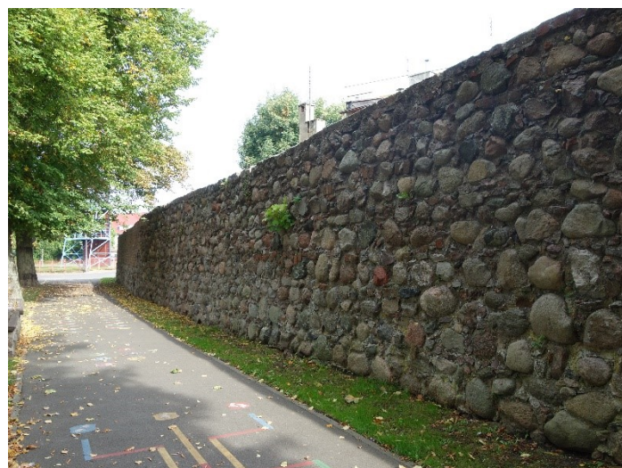
Odcinek muru nr.1 narożnik ceglano kamienny wraz z murem porośnięty glonami i chwastami. Spoiny zabrudzone miejscami spękańe
