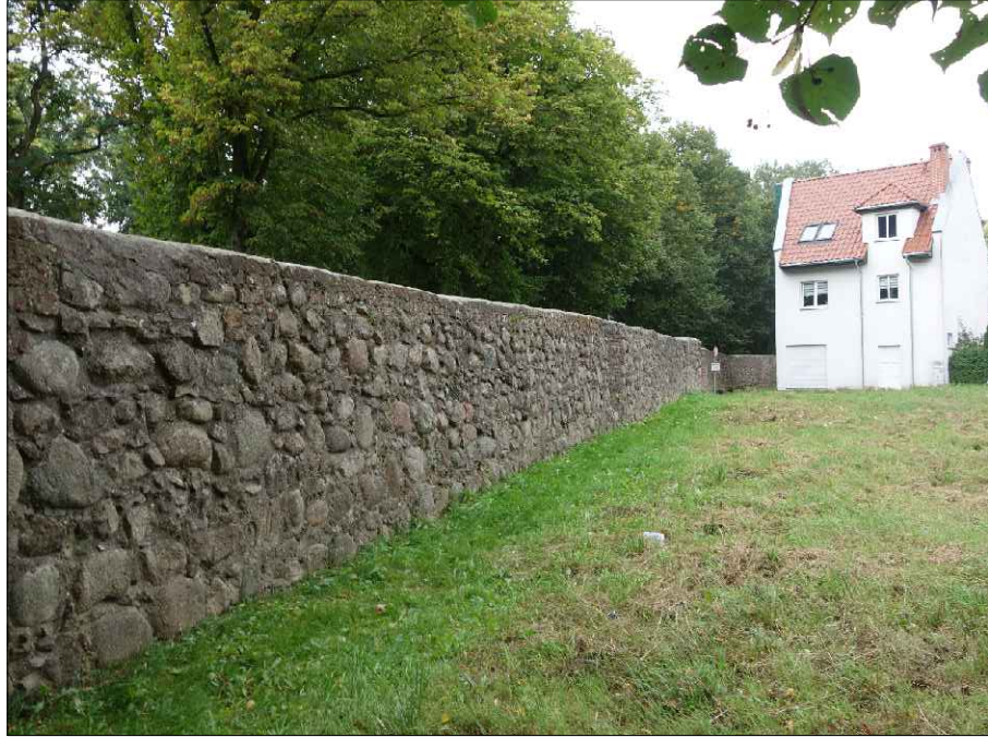
Mur kamienny i korona porośnięta gionami. Spoiny luzne wypuklane do uzupełnienia
