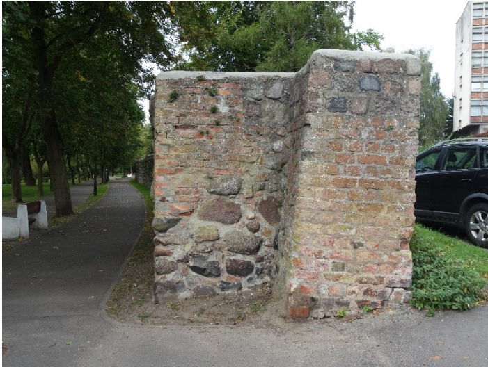
Odcinek nr.3 Narożnik, cegła wyszczerbiona, kamień porośnięty glonami .Odcinek muru z łękami porośnięty glonami ubytki zaprawy w spoinach .
