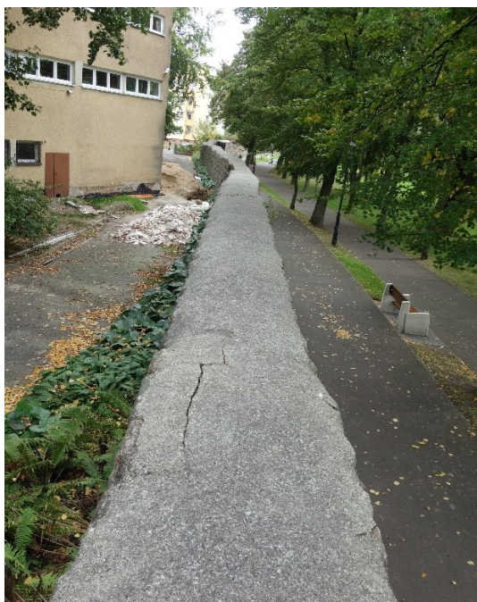
Korona muru wykończona szlichta cementową ( pęknięcie odc. 2 muru
