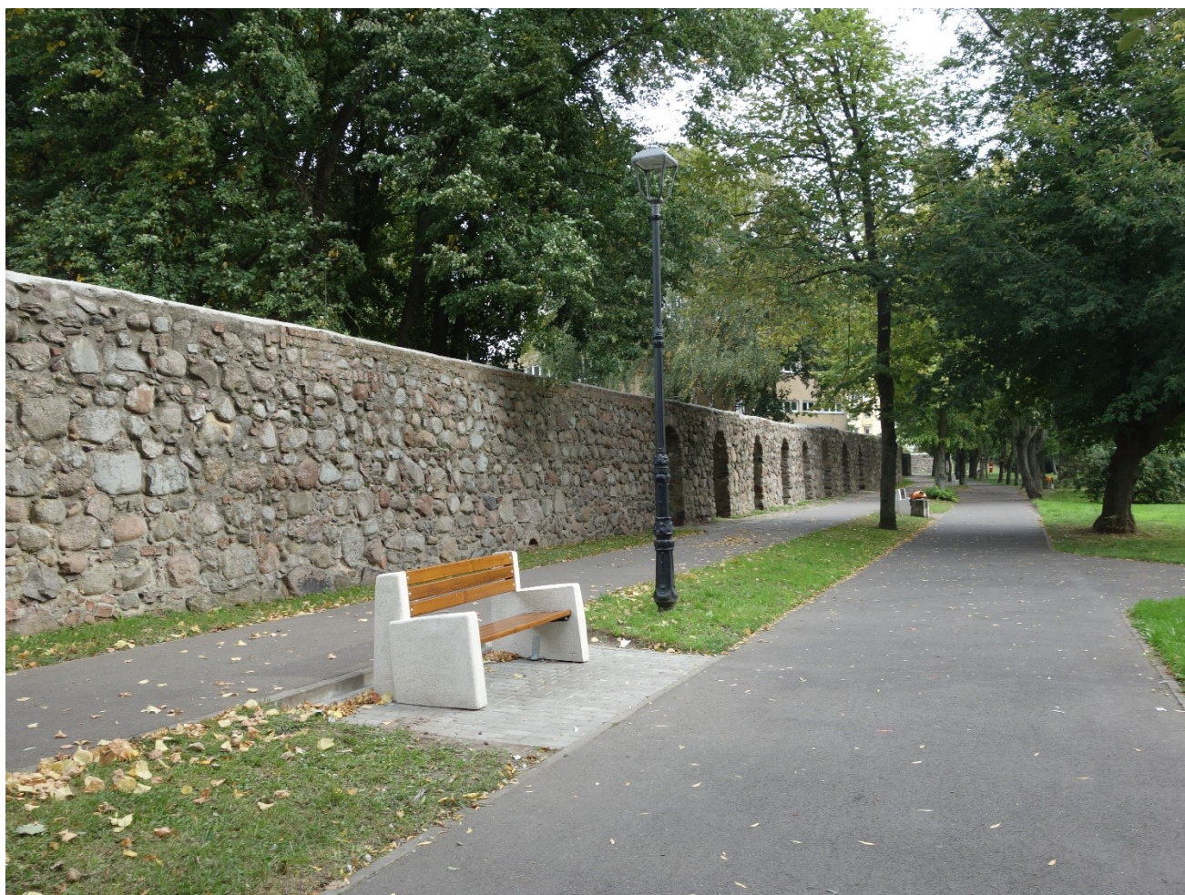
Odcinek muru z łękami kamiennymi w dobrym stanie technicznym.
